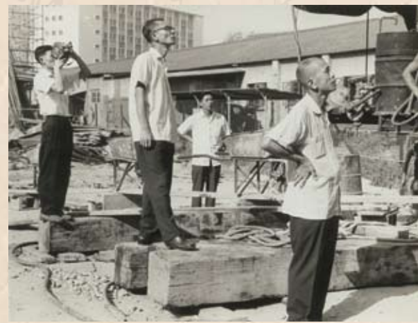
工聯會及籌建工人大會堂委員會負責人在工地視察，陳耀材（左二）、楊光（左三）、李生（右一）。
